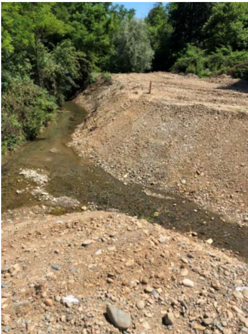
FOTO 1 – Stato attuale tratto di canale già parzialmente realizzato in scavo in prossimità del laghetto esistente intersezione con fosso esistente
